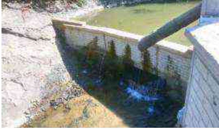
Şekil 1. 33. Düzce İli sınırlarından geçen derelere yapılan müdahaleler (Kalkın Deresi)
