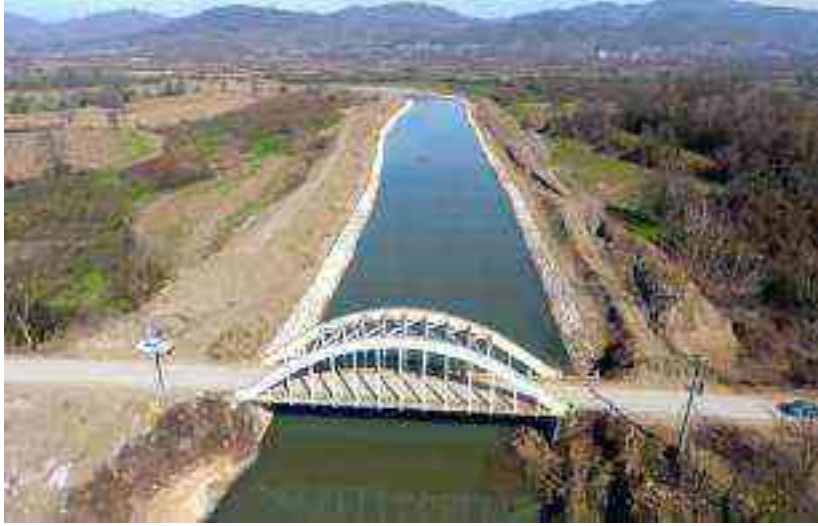
Şekil 1. 28. Düzce İli derelerindeki taşkın koruma tesisi örnekleri (Büyük Melen Çayı)
