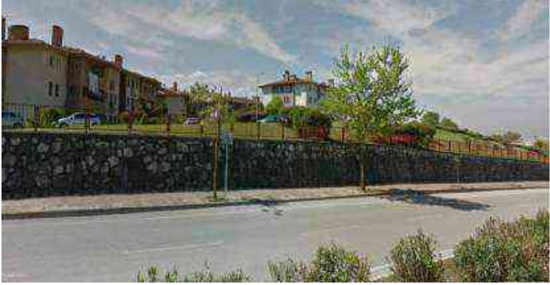
Şekil 1. 23. Heyelan Oluşumunu Önlemek İçin Yapılan Taş Duvar İstinat Duvarı
