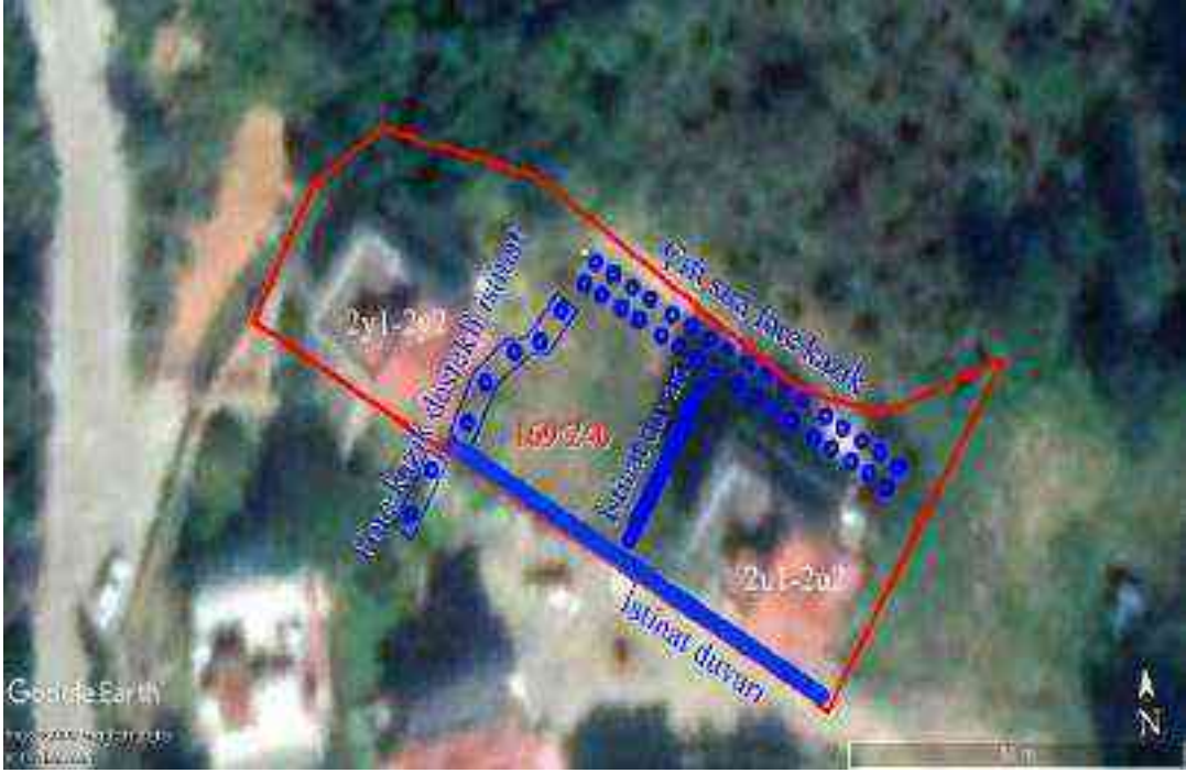
Şekil 1. 26. AMB Alanında Yapılmış Heyelan Önleme İksa Yapılarını Gösterir Görüntü
